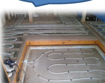
玄関土間配管
