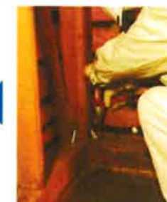
④断熱材を入れて、構造用合板を取り付け。
